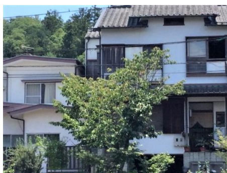
建物の正面全景
