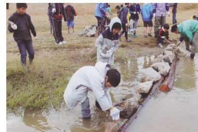
間伐材や自然石の配置作業
